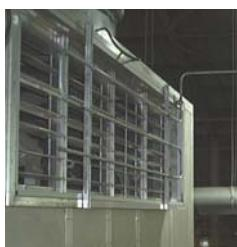
Un punto di campionamento dell'aria in corrispondenza della griglia di immissione di aria pulita può essere utile per compensare l'eventuale polvere proveniente dall'esterno ed evitare così possibili falsi allarmi.
