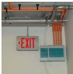
Nelle strutture più piccole, è possibile utilizzare un unico rilevatore VESDA per controllare aree distinte, come ad es. il soffitto, le griglie di ritorno aria e l'intercapedine sottopavimento.
