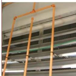
Il fumo in un locale dotato di impianto di condizionamento viene convogliato attraverso il flusso d'aria nella griglia dell'aria di ritorno, anziché al soffitto. Il punto di campionamento VESDA può quindi essere installato in corrispondenza della griglia per consentire la rilevazione tempestiva del fumo.
