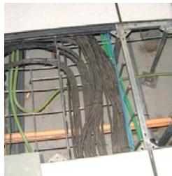
La tubazione di campionamento VESDA può essere installata, all'interno di sottopavimenti, in corrispondenza delle canaline passacavi (zona ad alto rischio) in modo da assicurare la tempestiva rilevazione del fumo anche in quest'area.
