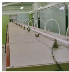
La tubazione di campionamento VESDA si ramifica in una rete di capillari che aspirano l'aria direttamente all'interno dei singoli armadi consentendo così una rilevazione tempestiva.
